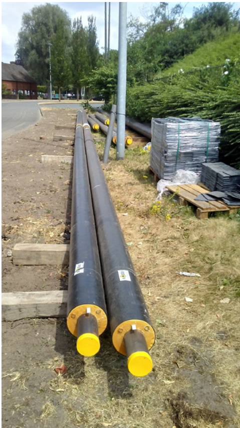
Buizen warmtenet. Foto: BBL
