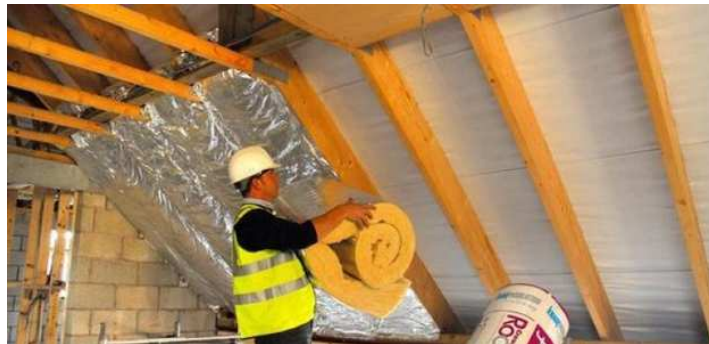
Figuur 45 - Voorbeeld plaatsing dakisolatie (bron: KNAUF)
