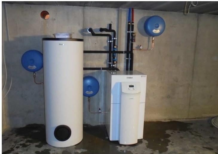
Figuur 54 - Voorbeeld van een residentiële warmtepomp (bron: geoservices.be)
