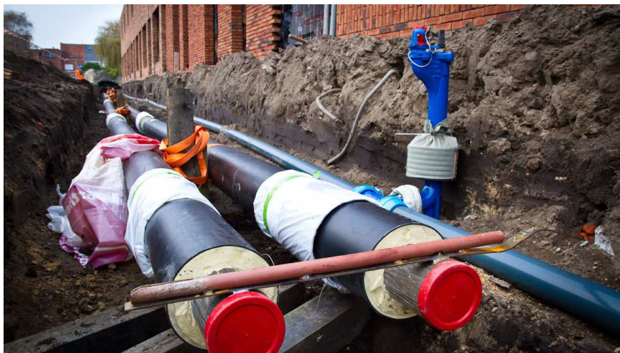
Figuur 48 - Aanleg van het warmtenet Niefhout fase 1 te Turnhout (bron: SlimTurnhout.Be)
