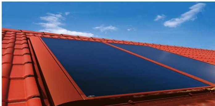
Figuur 55 - Voorbeeld van een thermische vlakplaatcollector geïntegreerd in het dakvlak (bron: belsolar )
